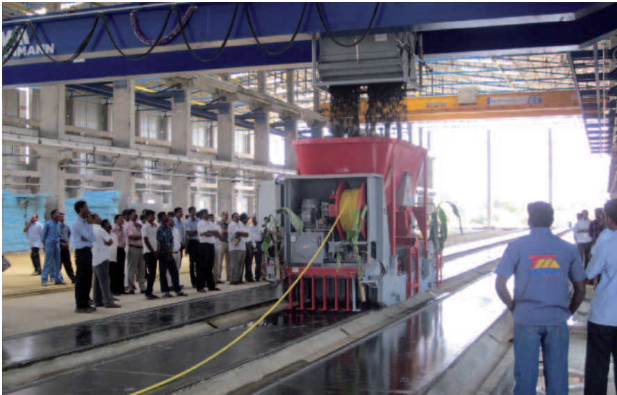
A moldadora deslizante para a produção de piso é automática e continuamente abastecida de concreto
