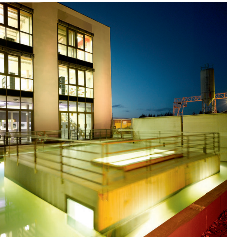
Der schwimmende Keller der Firma Bürkle
