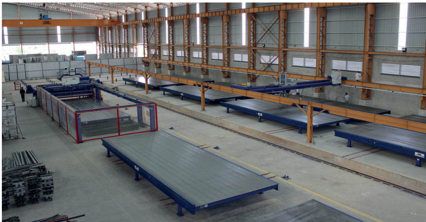
Instalación de circulación de plataforma corrediza central
