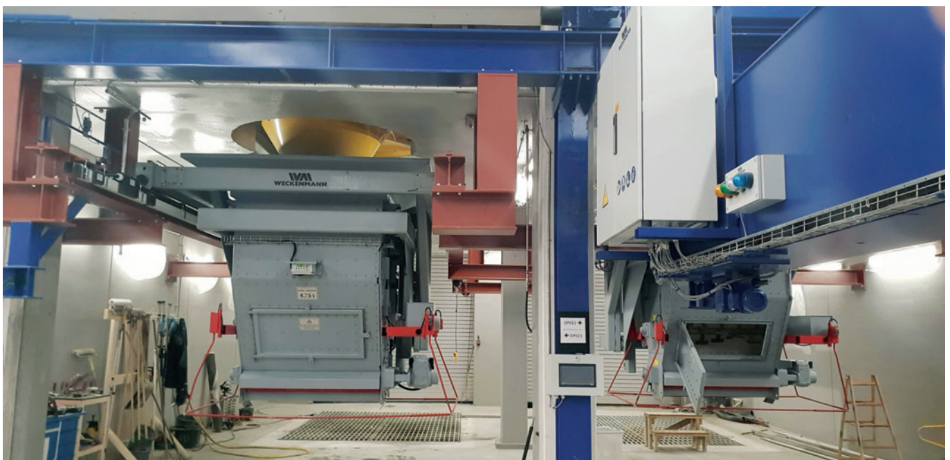
Бетонораздатчик с двумя линиями адресной подачи бетонной смеси
