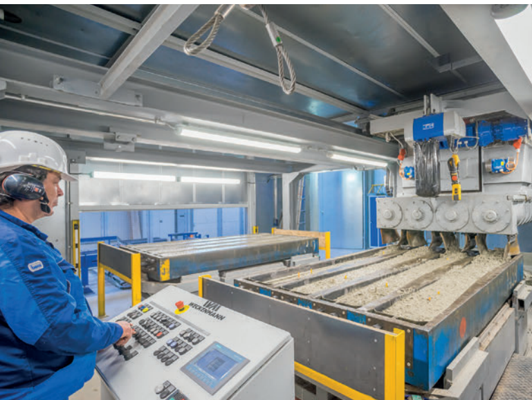
Estación de hormigonado
