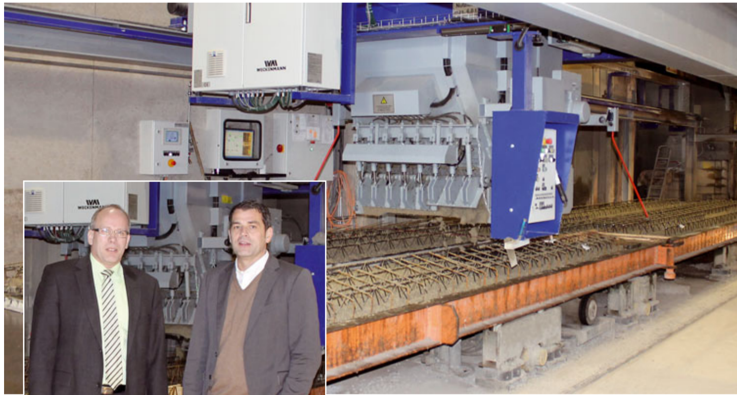
При помощи автоматических бетонораспределителей Weckenmann (см. фото сверху) компания fdu Vertriebs- und Planungs GmbH под руководством управляющего Томаса Байке (на фото справа) и руководителя проекта Бенно Штрака оптимизировали производство на своих 4 заводах.
