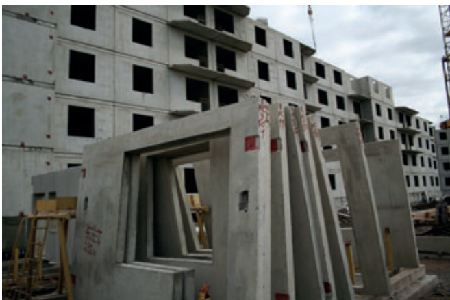
Le nouveau système de construction de maisons de Blok remplace le système traditionnel de construction sandwich par un système de murs porteurs et un système composite d'isolation thermique
