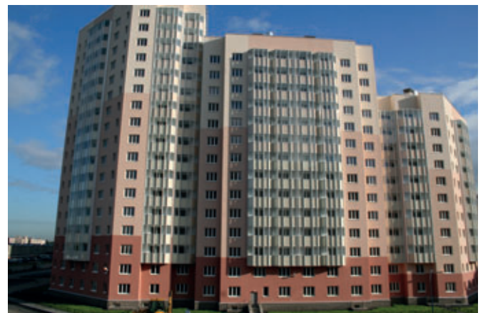
Grâce à la mise en œuvre de la technologie allemande moderne, les ensembles résidentiels peuvent être réalisés plus rapidement et dans une meilleure qualité.
