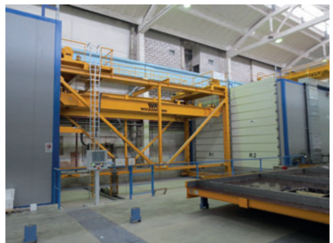
Chambre de durcissement avec chauffage à air chaud
