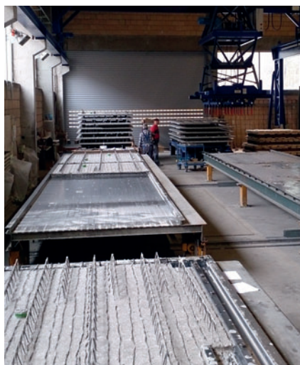
После: распалубка на двух позициях в три штабеля с двумя разгрузочными тележками
